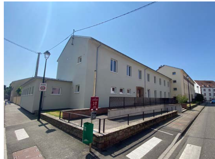
Même vue après les travaux
