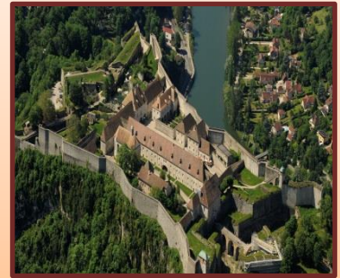
Vue aérienne de la Citadelle
