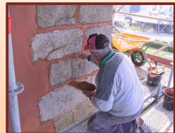
Restauration des enduits
